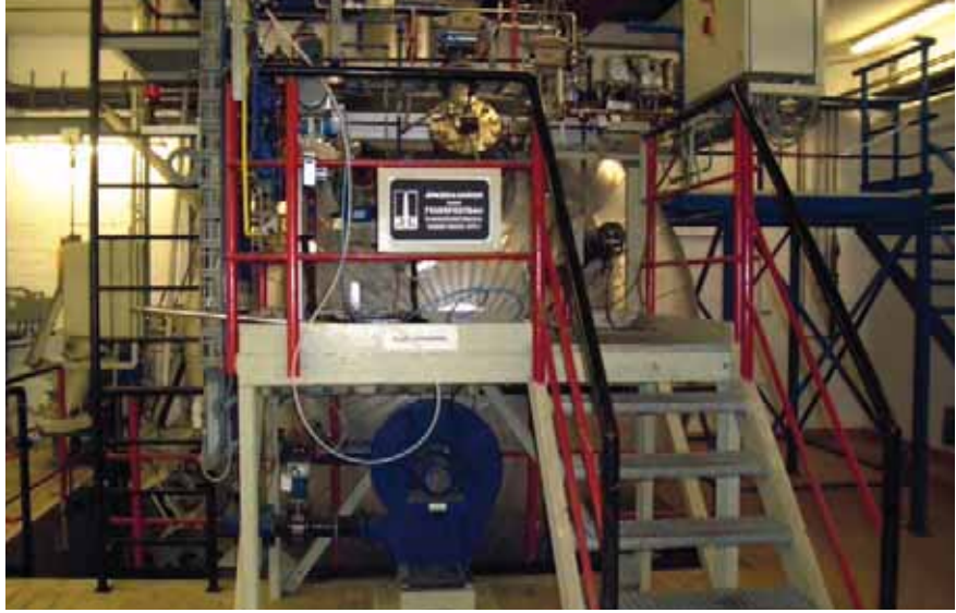
Anlage zur Vernichtung der Chemiewaffen bei der Firma GEKA
